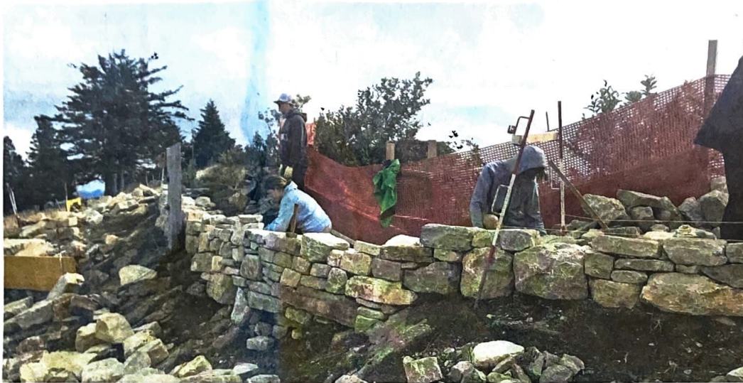
Völkerverbindend wirkt das Trockenmauer-Bauen auf dem Grenchenberg.
